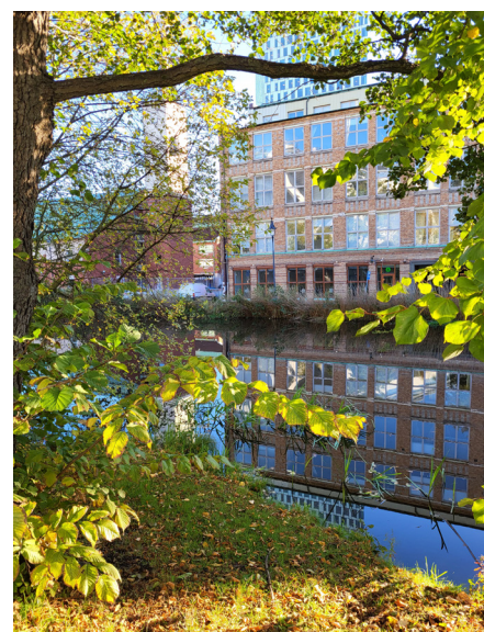
Industribyggnader möter hårdgjord kaj intill vattnet.
